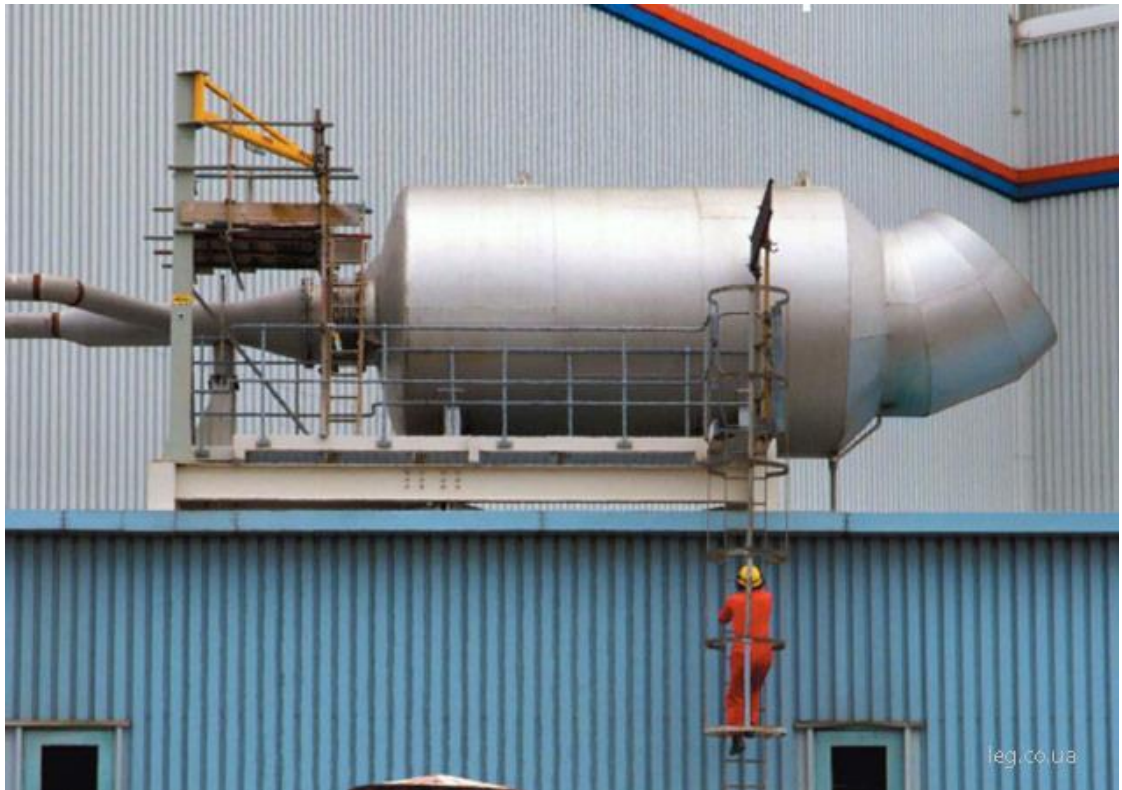
Рисунок 3.4 – Загальний вигляд глушнику реактивного типу
