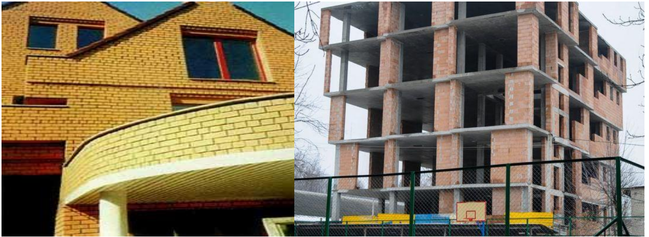
Рисунок 2.5 – Будівлі каркасно-монолітної схеми
