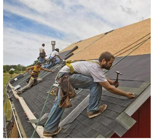
Рисунок 2.26 – Монтаж бітумної черепиці
