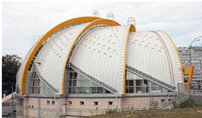
Рисунок 2.17 - Фальцювальна покрівля
