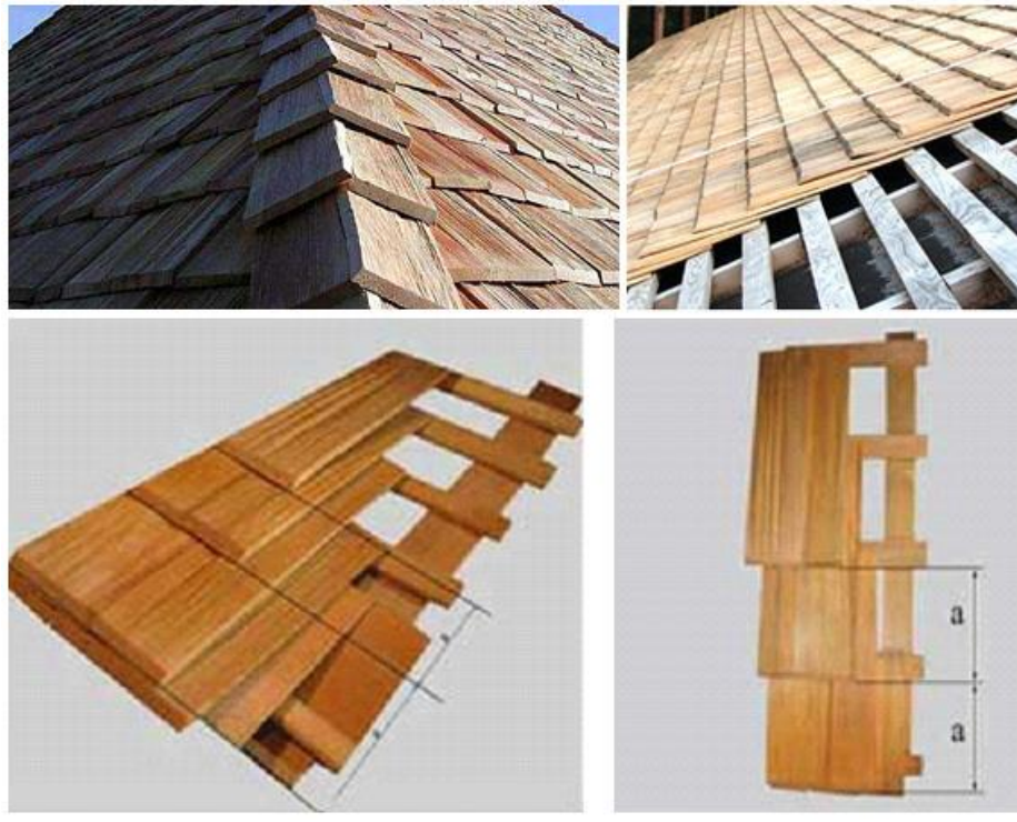
Рисунок 1.6 - Конструкція гонтової покрівлі
