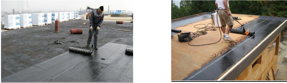
Рисунок 1.1 - Укладання покрівельного килима
