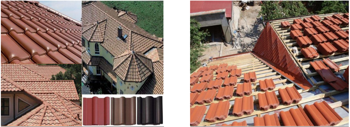
Рисунок 2.23 - Покрівля з цементно-піщаної черепиці
