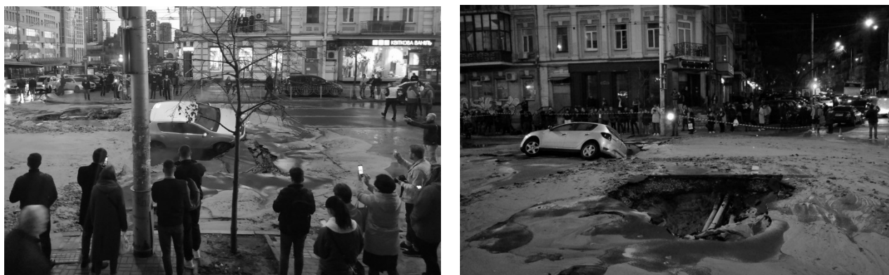
Рис. 5. Провал на центральних вулицях Києва з-за прориву теплотраси
