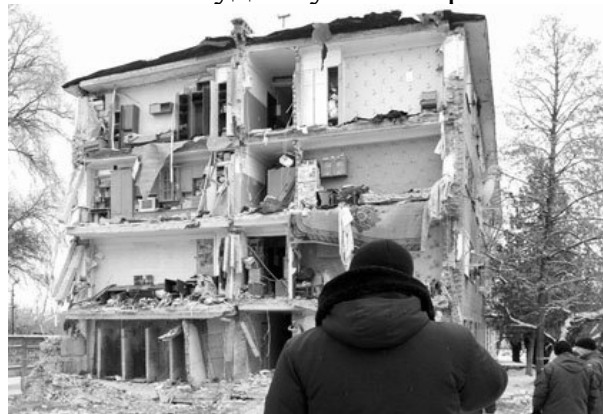
Рис. 1. Обрушення плит перекриття житлового будинку в м. Чернігів
