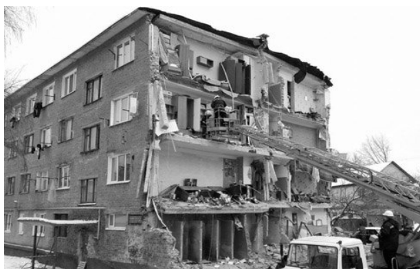
Рис. 2 Вид будівлі в м. Чернігів після демонтажу торцевої частини
