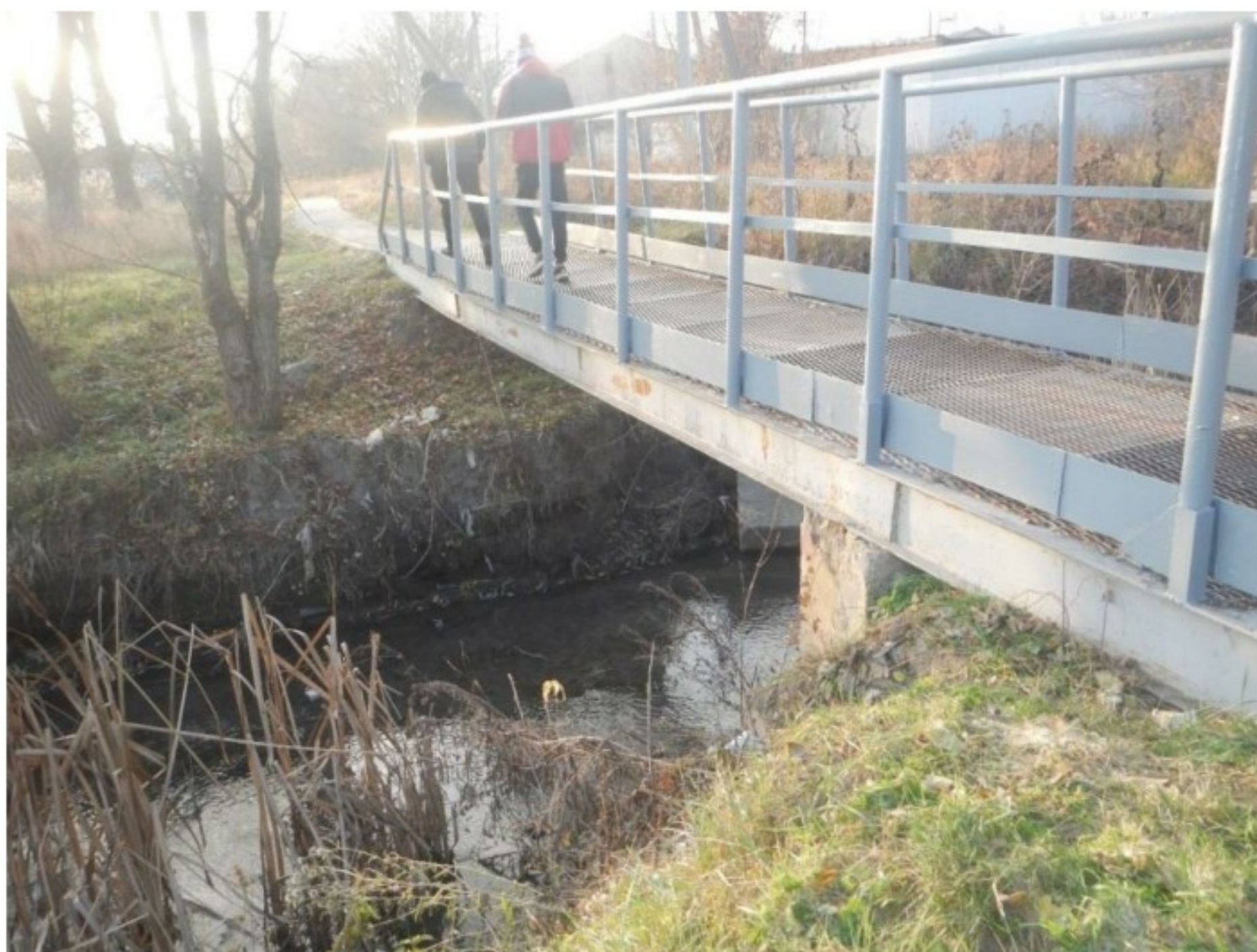
Рисунок 3.7 Перильна огорожа мостової споруди не відповідає нормативним вимогам
