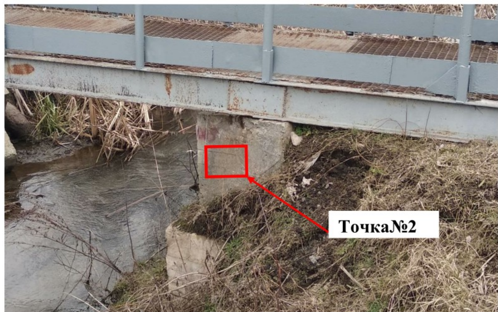
Рисунок 3.19 Зовнішній вигляд точок визначення міцності бетону на об'єкті.
