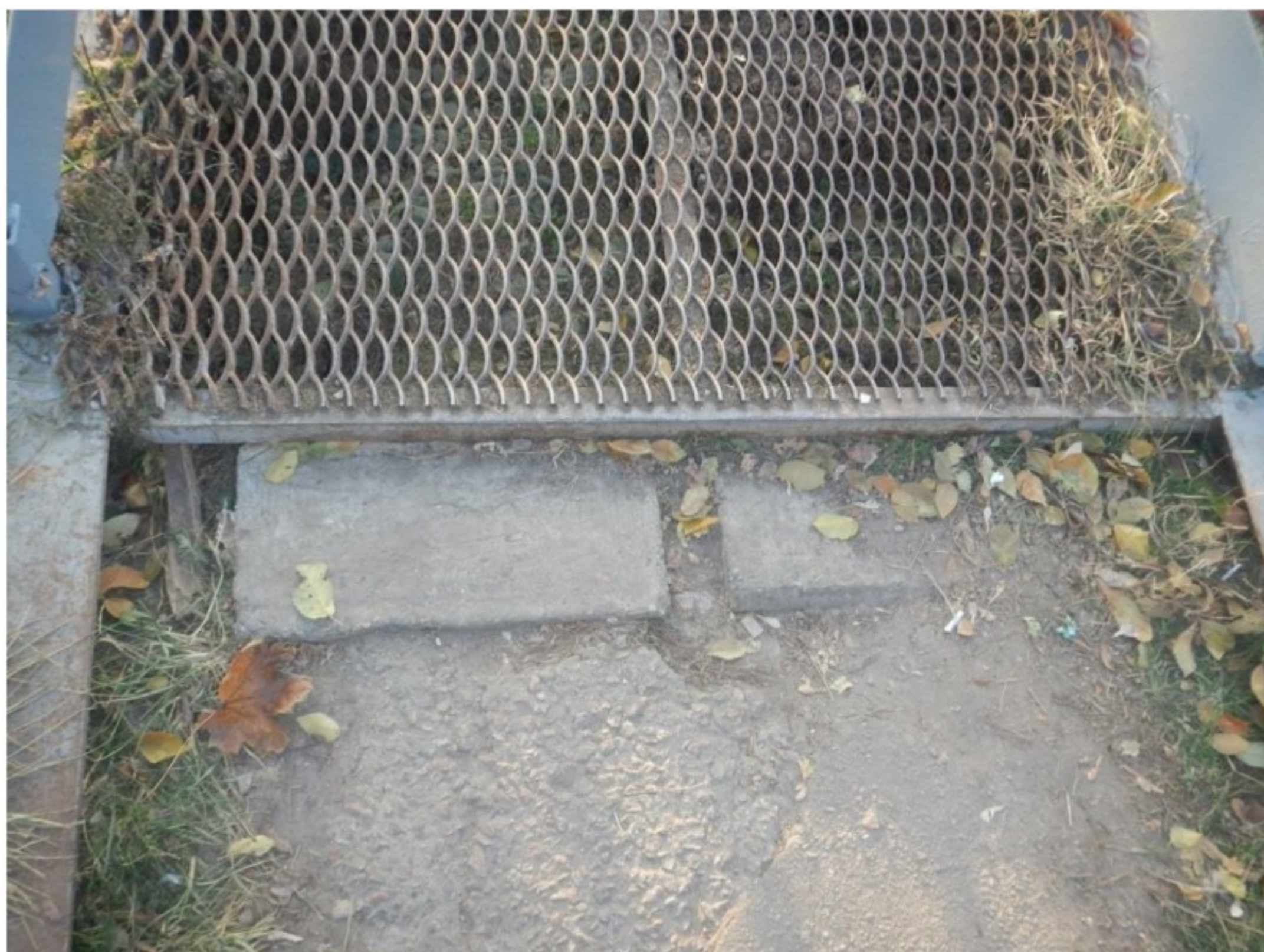
Рисунок 3.13 Відсутність пандусу, належного підходу до мосту.
