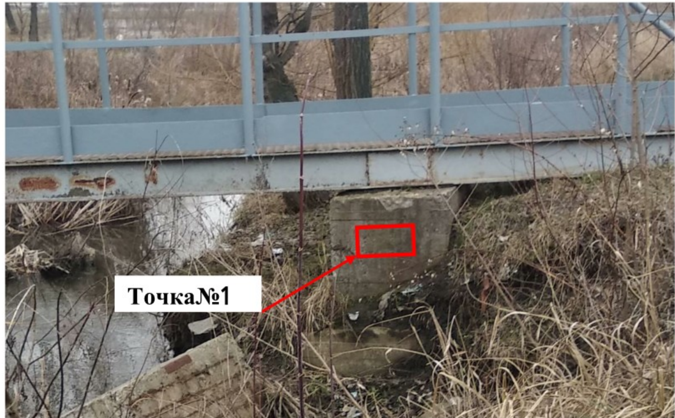
Рисунок 3.18 Зовнішній вигляд точок визначення міцності бетону на об'єкті.
