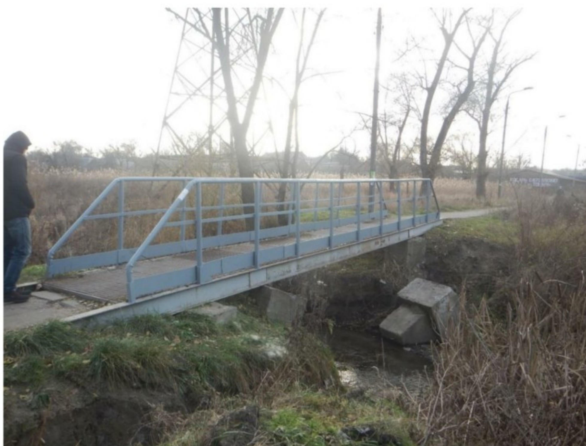
Рисунок 3.8 Відсутність освітлення по всій території споруди
