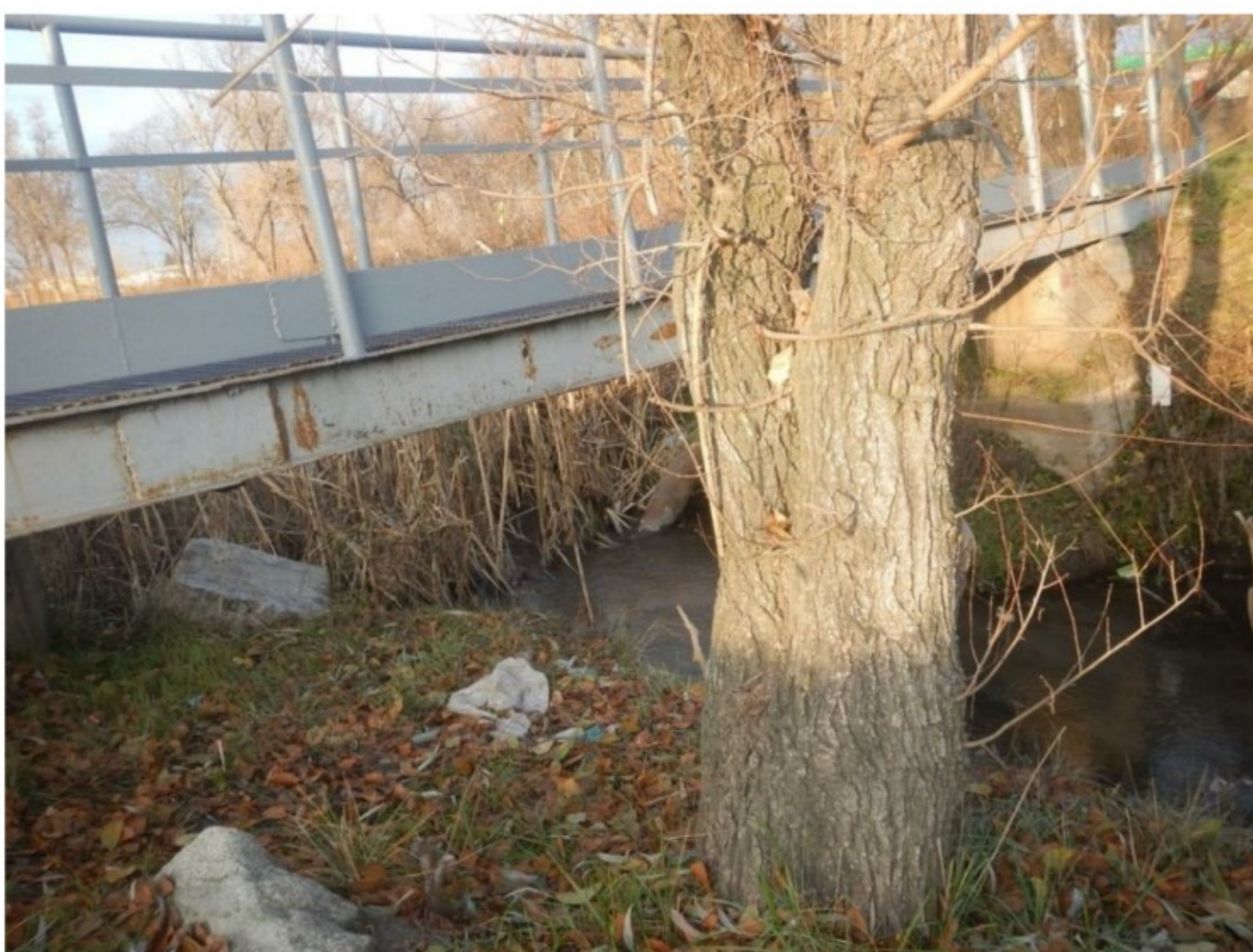
Рисунок 3.10 Проростання дерев та чагарників в безпосередній близькості до прогонових будов
