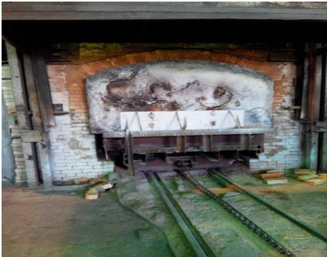
Рисунок 2.8 – Загальний вигляд камерної печі під час відпалу металу
