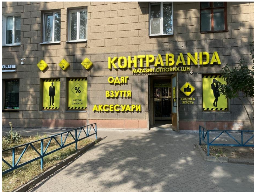
Рис. А.7. Зміни на фасаді будівлі по проспекту Металургів, №16.
