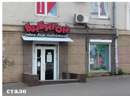
Рис. А.4. Зміни на фасаді будівлі по проспекту Соборному, №173.
