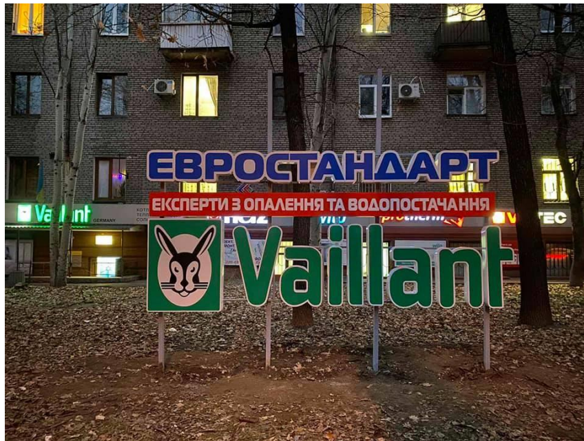
Рис. А.14. Демонтаж реклами по вулиці Незалежної України, №49.
