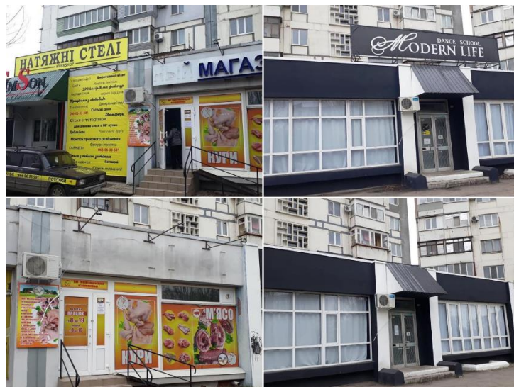
Рис. А.11. Демонтаж вивісок по вулиці Товариській, №37.
