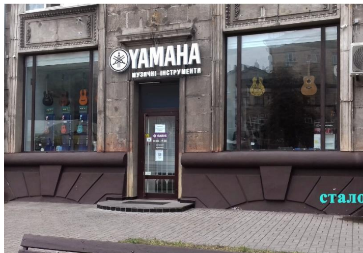
Рис. А.1. Зміни на фасаді будівлі по проспекту Соборному №159.
