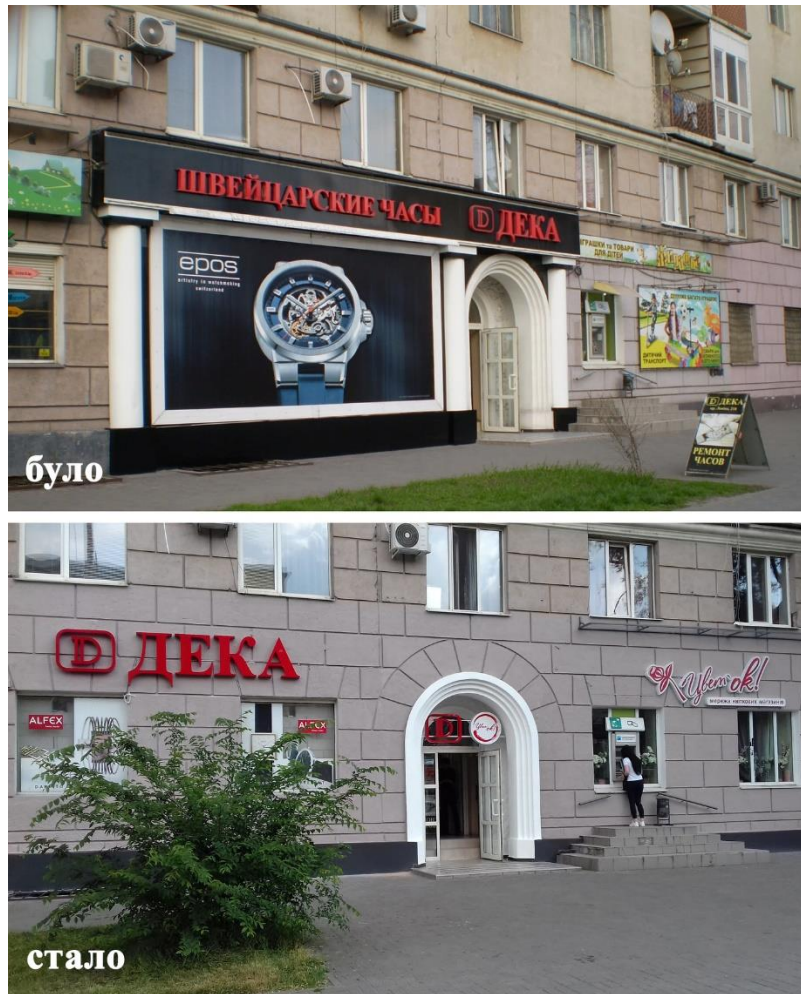
Рис. А.5. Зміни на фасаді будівлі по проспекту Соборному, №218.
