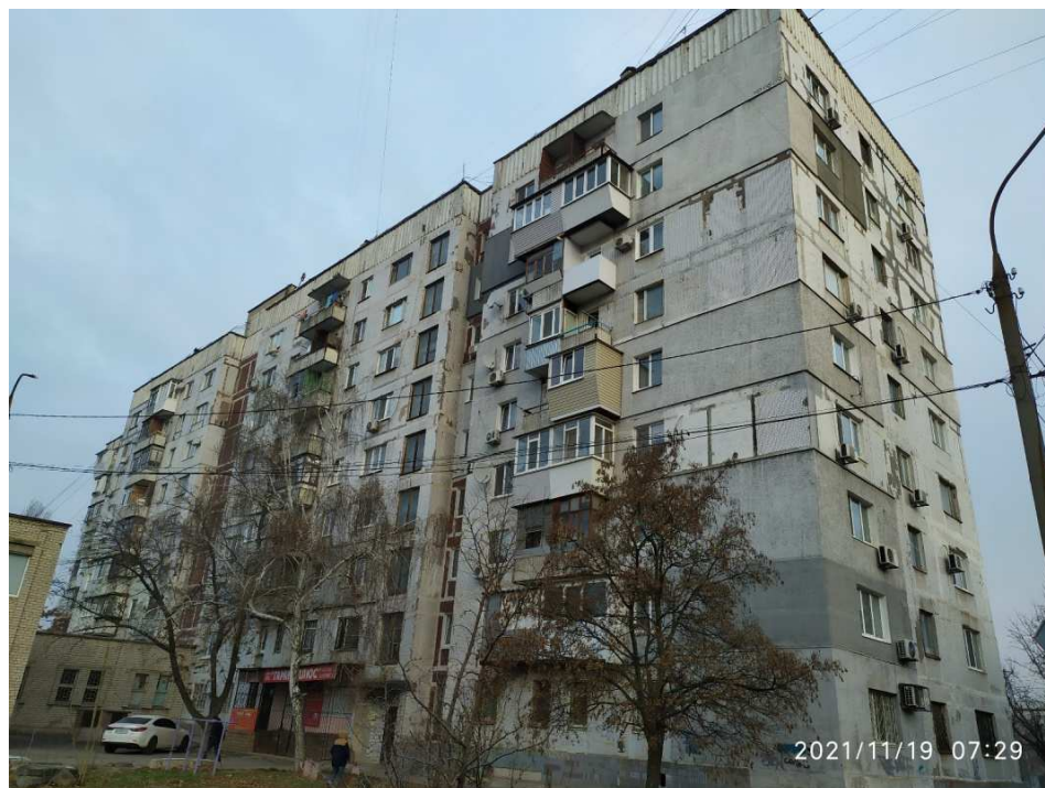
Рисунок 3.10 - Загальний вид будівлі
