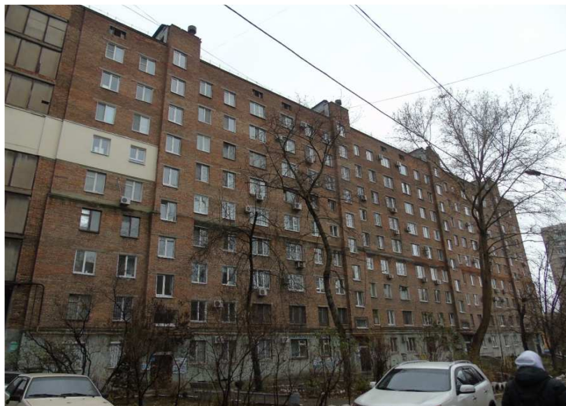
Рисунок 3.24 – Загальний вид житлової будівлі з дворового фасаду
