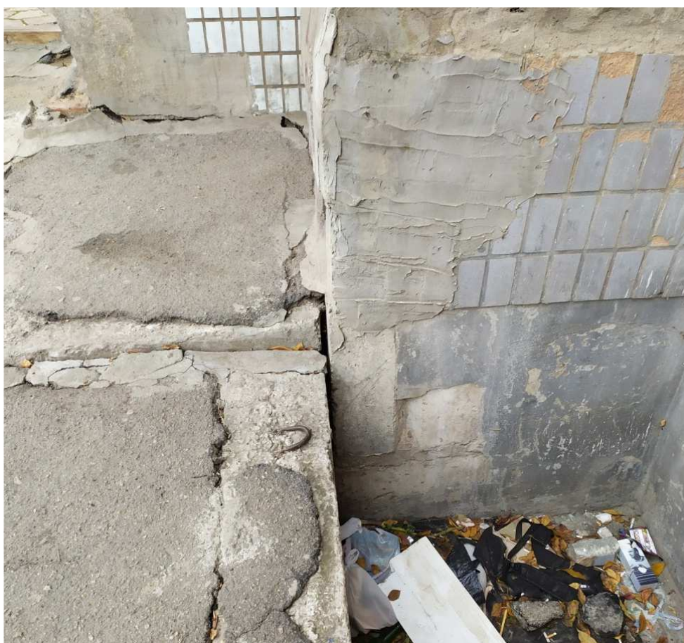
Рисунок 3.13 – Тріщина коло прямоку та входної двері
