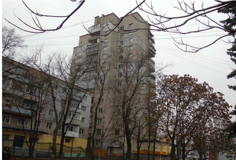
Рисунок 3.22 – Загальний вид будівлі
