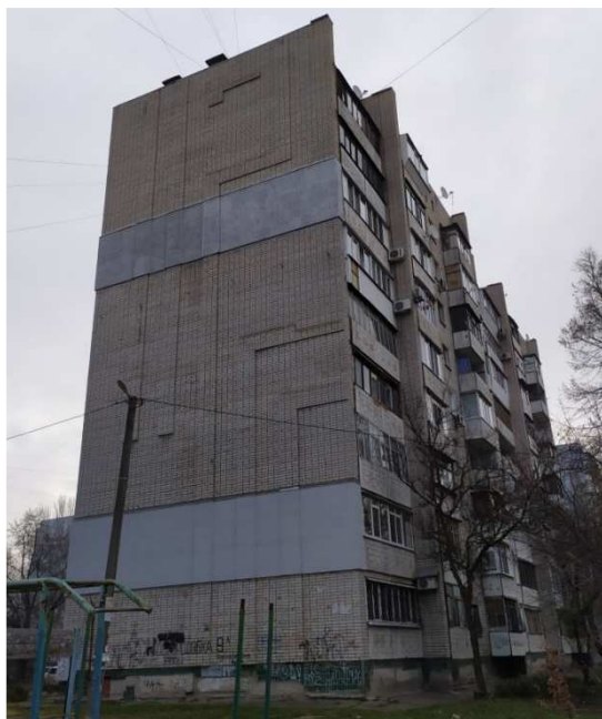
Рисунок 3.15 – Загальний вид будівлі
