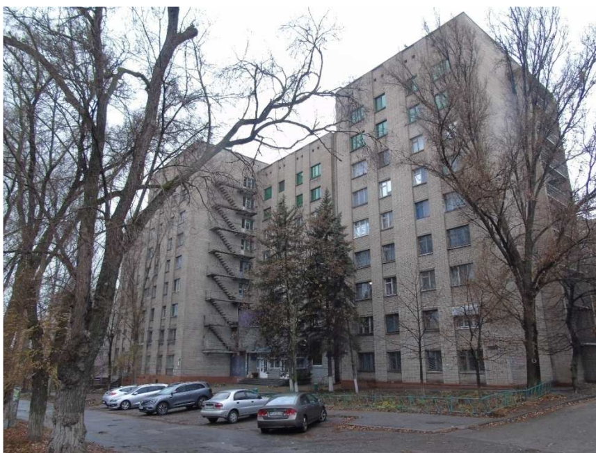
Рисунок 3.19 – Загальний вид будівлі гуртожитку
