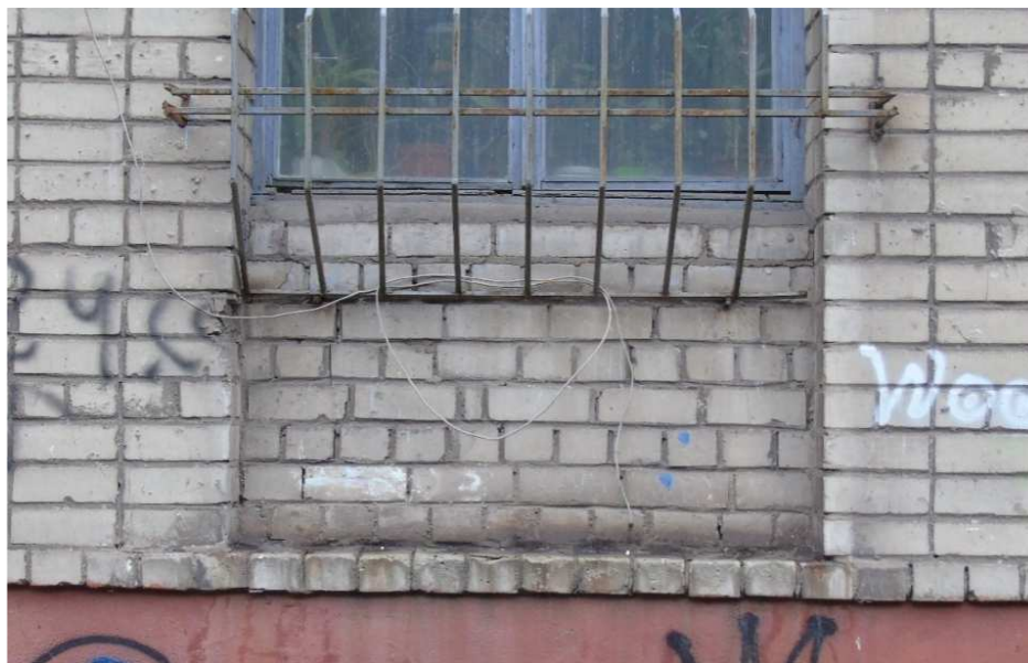
Рисунок 3.20 – Розкриття тріщин
