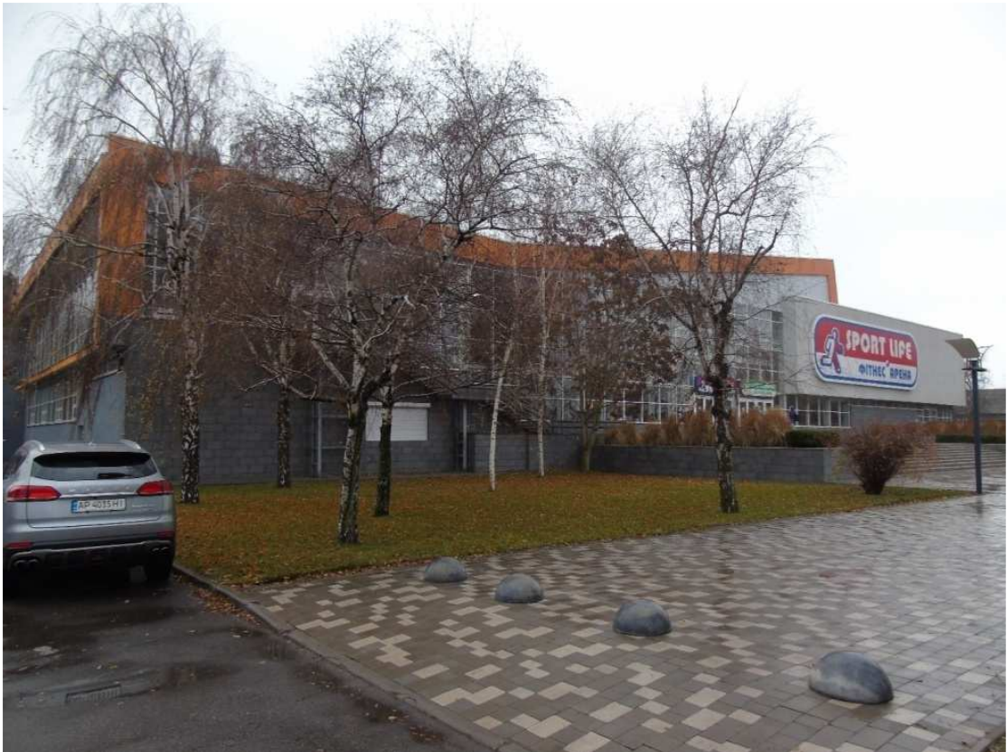
Рисунок 3.17 – Загальний вид будівлі легкоатлетичного манежу
