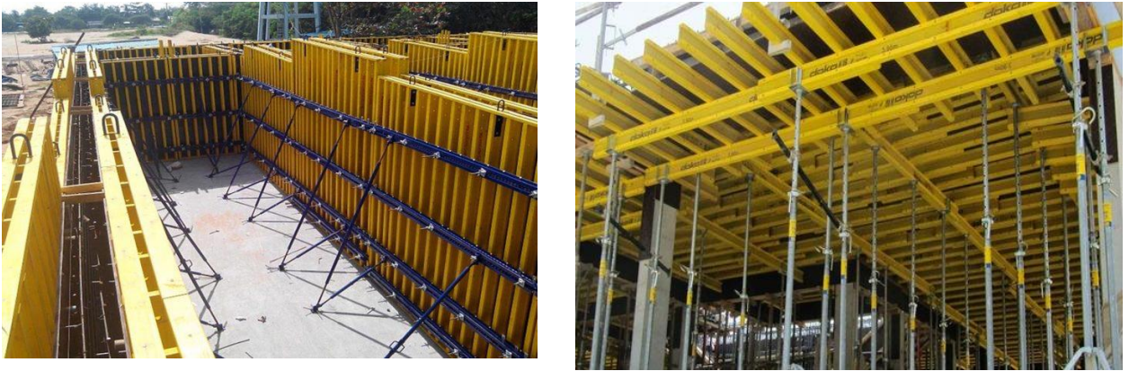
Рисунок 1.2 – Опалубна система «Doka»
