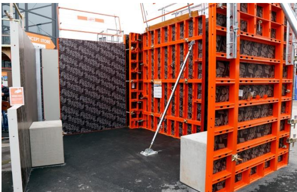
Рисунок 1.1 - Опалубна система «Paschal»
