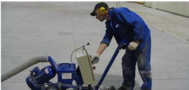
Рисунок 1.2 - Піскоструменева підготовка поверхні
