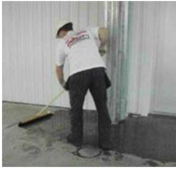
Рис. 3.1 Нанесення композиції Літурін 1
