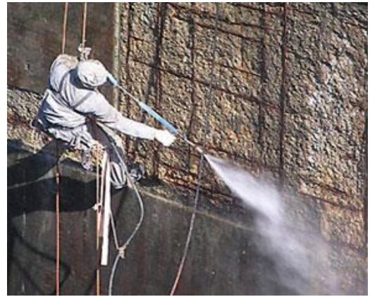
Рисунок 1.4 – Очищення поверхонь водою під тиском
