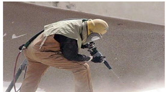
Рисунок 1.2 - Піскоструменева підготовка поверхні
