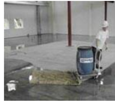
Рис. 3.1 Нанесення композиції Літурін 1
