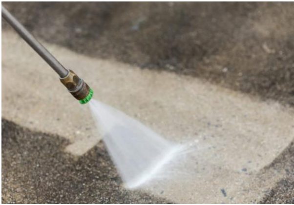
Рисунок 1.4 – Очищення поверхонь водою під тиском
