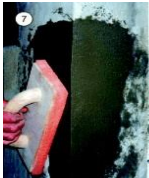
Рисунок 3.6 - Технологія нанесення «Максрайт 500»
