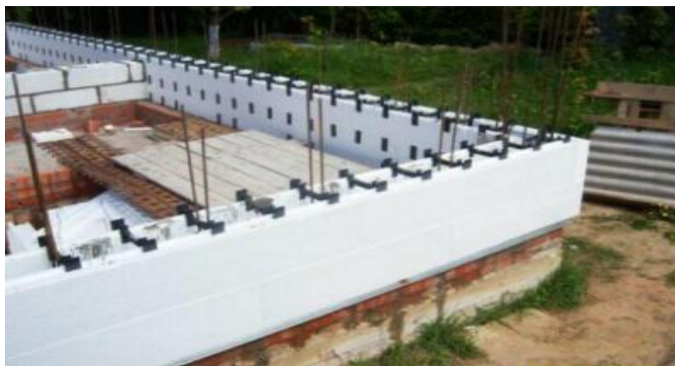
Рисунок 1.6 – Будівництво монолітних будинків.
