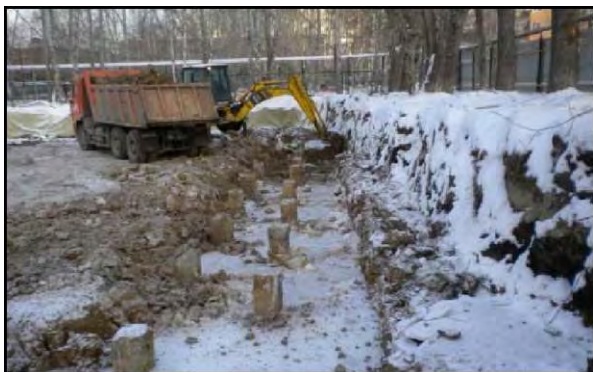
Рисунок 3.4 - Відкопування траншеї під стрічковий ростверк
