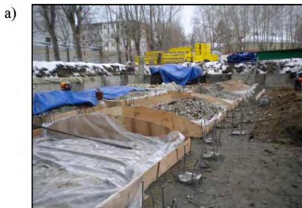
Рисунок 3.8 - Влаштування щебеневої подушки: а - укладання мембрани; б - засипання щебеню
