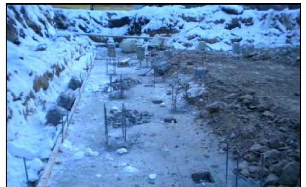
Рисунок 3.5 - Загальний вид бетонної підготовки
