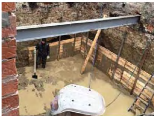
Рисунок 3.14 - Обвали та розструктурування ґрунтів під підшовою стрічкових ростверків (а) та технологічні рішення щодо забезпечення їх стійкості (б).
