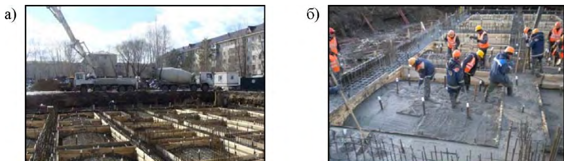
Рисунок 3.20 – Бетонування КППФ: а – загальний вигляд перед бетонуванням; б - загладжування поверхні оболонок
