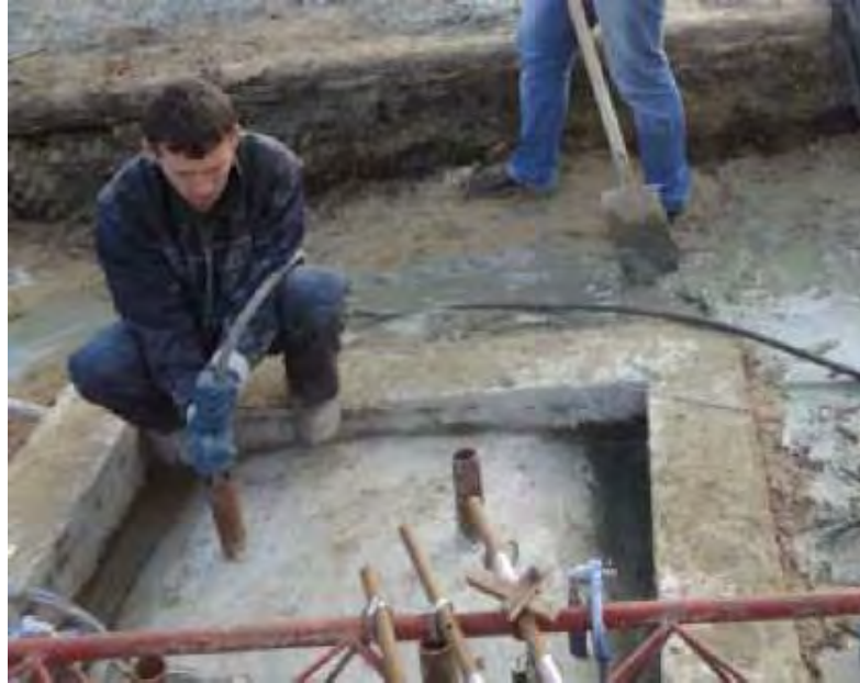
Рисунок 2.2 – Виконання нагнітання суміші в щебеневу подушку
