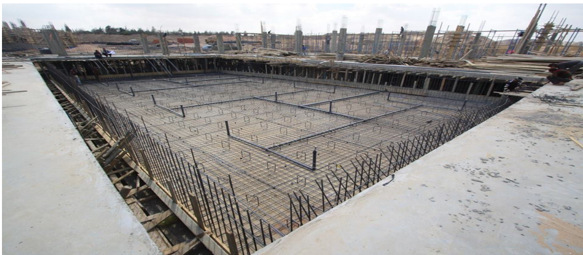
Рисунок 3.1 - Докладний фотозвіт про будівництво фундаменту в Марокко
