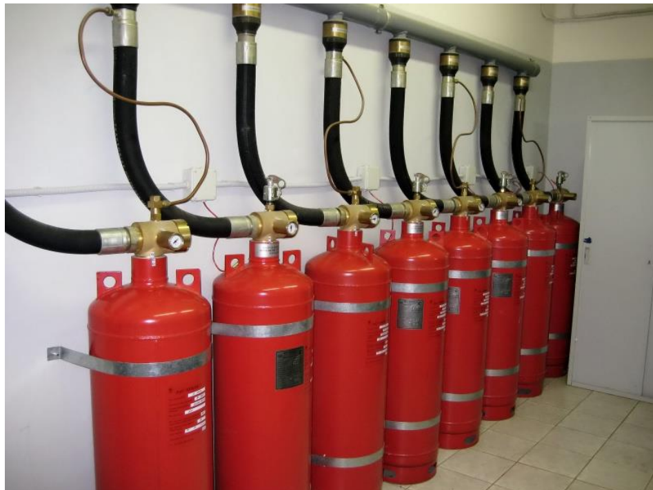
Рисунок 1.9 – Установка газового пожежогасіння
