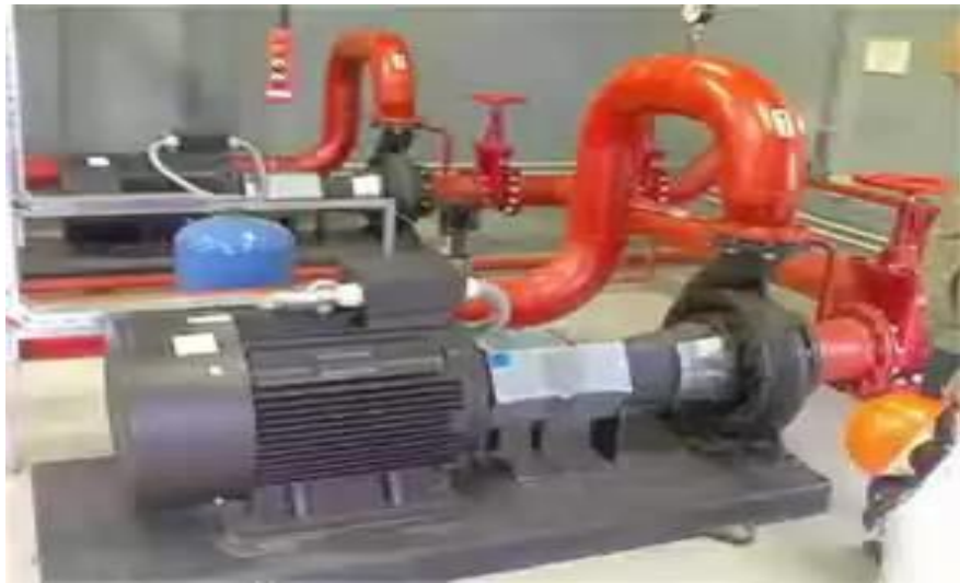
Рисунок 1.7 – Установа водяного пожежогасіння
