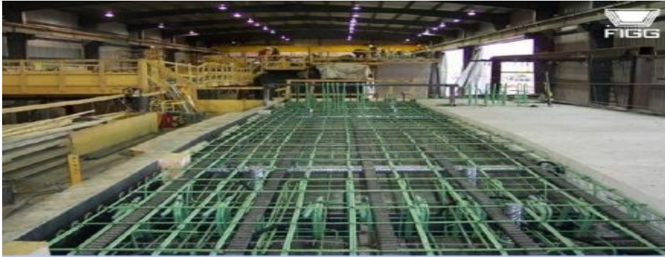
Рисунок 3.26 – Лиття сегмента короткої лінії
