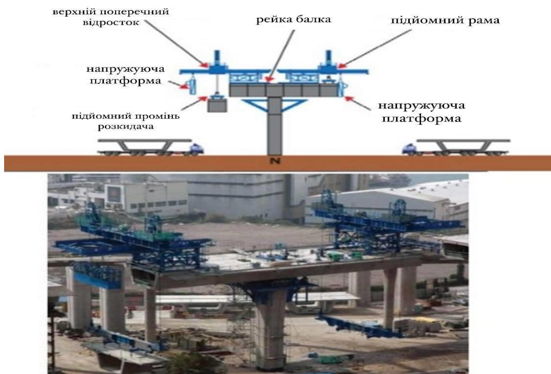
Рисунок 3.14 – деталі консольного способу будівництва моста (збірні сегменти)
