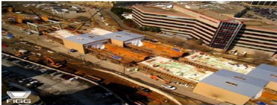
Рисунок 3.27 – Лиття сегмента довгої лінії
