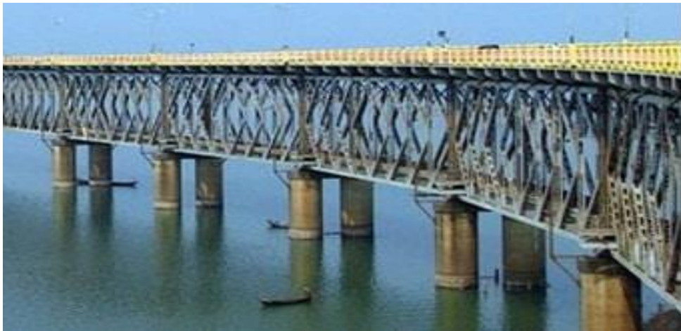
Рисунок 1.41 – Дорожній залізничний міст
