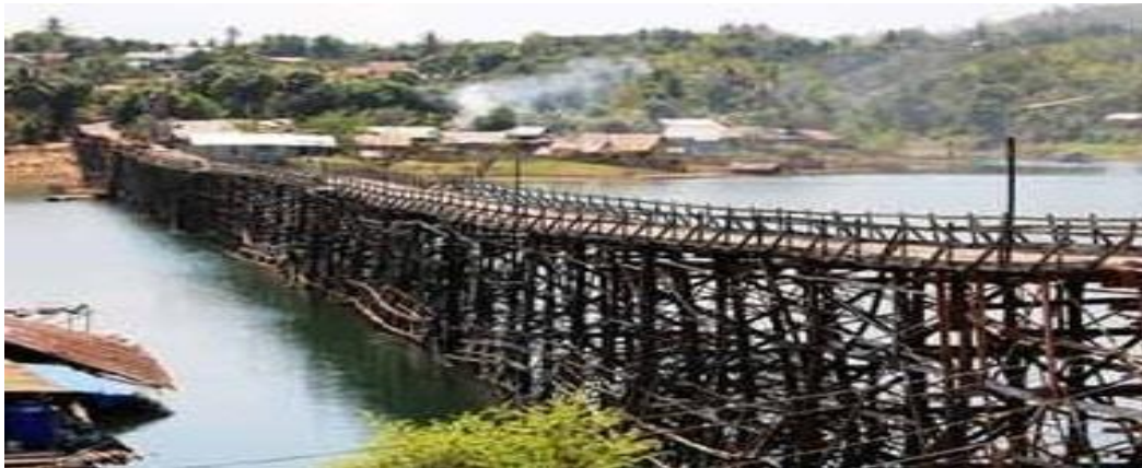
Рисунок 1.46 – Приклад тимчасового мосту
