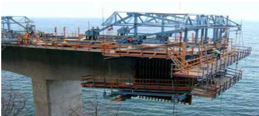
Рисунок 3.10 – Збалансований консольний метод будівництва
