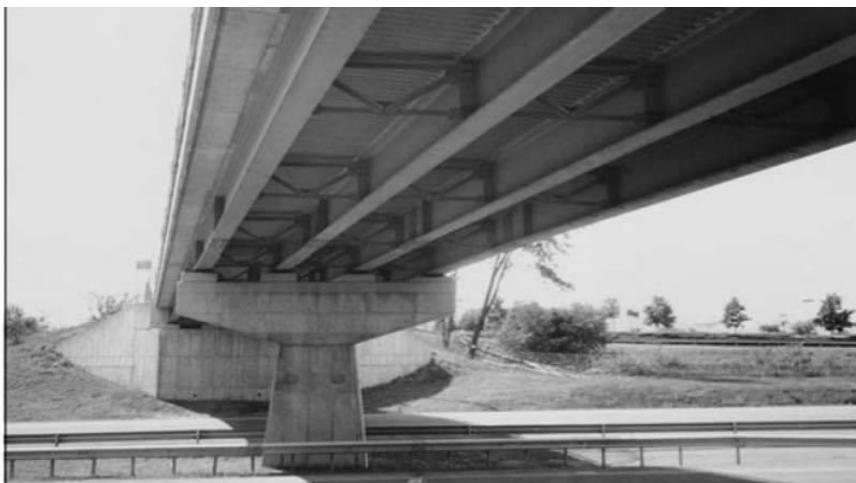
Рисунок 1.7 – Пристань-молот підтримує надбудову плити на стрингери
