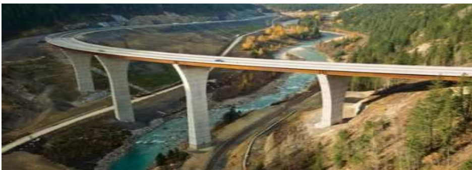
Рисунок 3.9 – Міст побудований за допомогою методу збільшення старту "Cast-in-situ"
