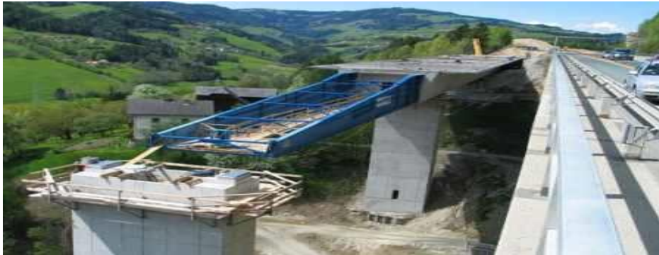
Рисунок 3.8 – Метод поступового запуску будівництва мостів
