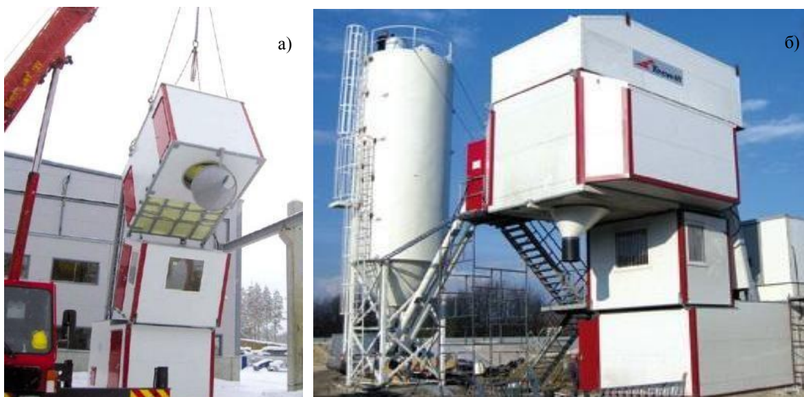
а – монтаж заводу; б – загальний вигляд
