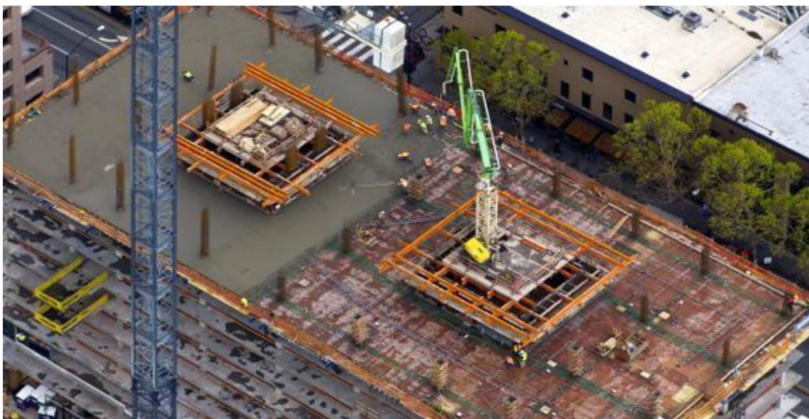
Рисунок 1.2 – Бетонування конструкцій самопідйомною гідравлічною розподільною стрілою Putzmeister (м. Лос-Анджелес, США)
