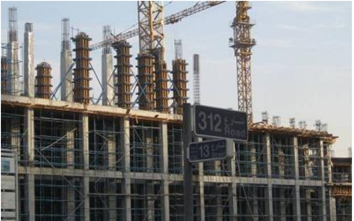
Рисунок 1.3 – Зведення каркасу будівлі з використанням традиційних опалубних систем (м. Дубай, ОАЕ)
