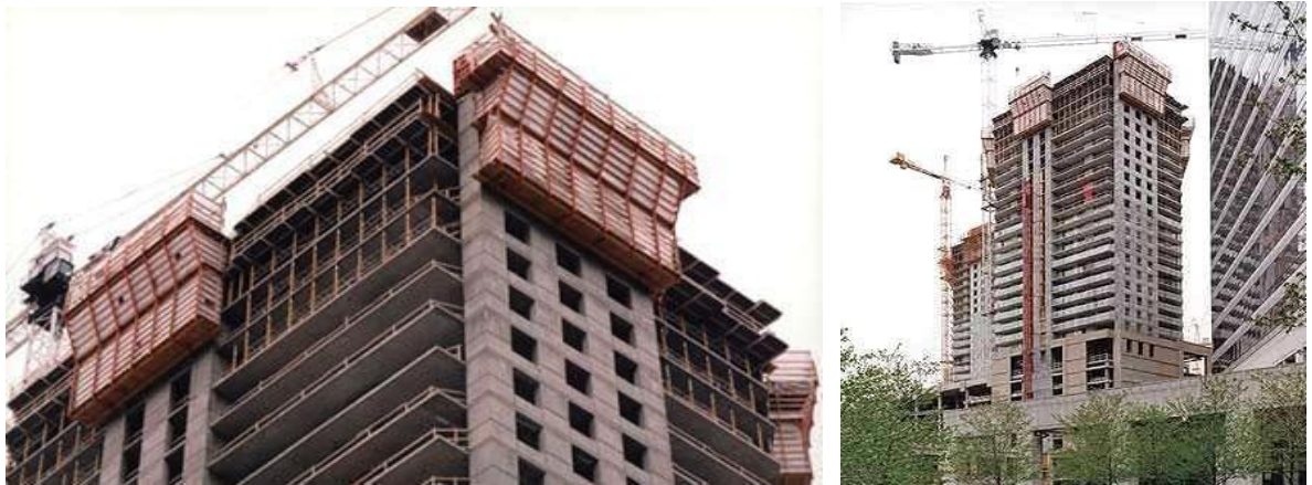
Рисунок 1.4 – Зведення будівлі “The Grand Plaza” за допомогою систем ковзної опалубки Peri ACG (м. Чикаго, США)
