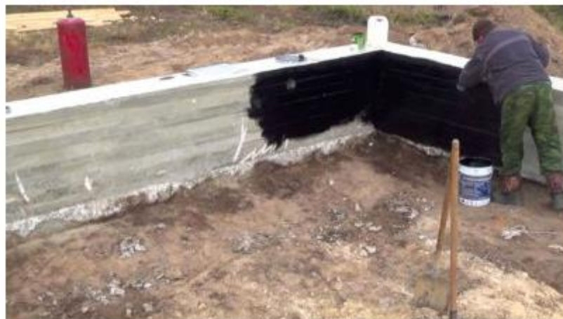
Рисунок 2.4 - Гідроізоляція фундаментів ТІСЕ
