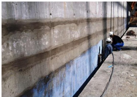
Рисунок 4.2 - Нанесення ґрунтовки на бетонну поверхню
