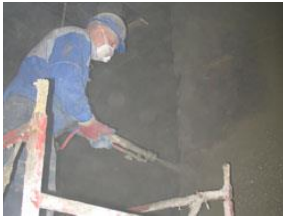
Рисунок 4.9 – Нанесення торкрет розчину на поверхню
