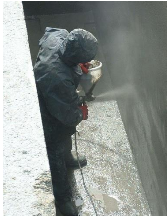
Рисунок 4.5 - Нанесення фарбувальної гідроізоляції гідродинамічним способом
