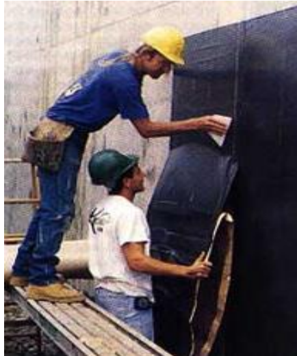
Рисунок 4.1 - Армування фарбувальної гідроізоляції синтетичними рулонними матеріалами
