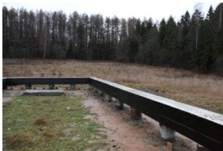
Рисунок 2.2 - Гідроізоляція свайно-ростверкових фундаментів
