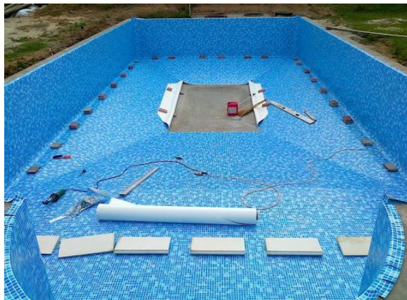
Рисунок 2.4 - Полімерні мембрани ПВХ (полівінілхлорид).
