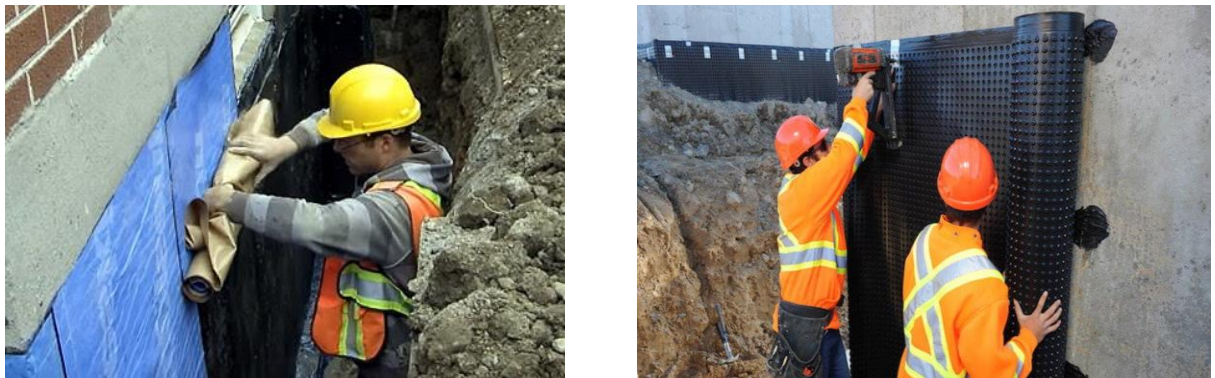
Рисунок 1.2 - Обклеювальна рулонна гідроізоляція фундаментів
