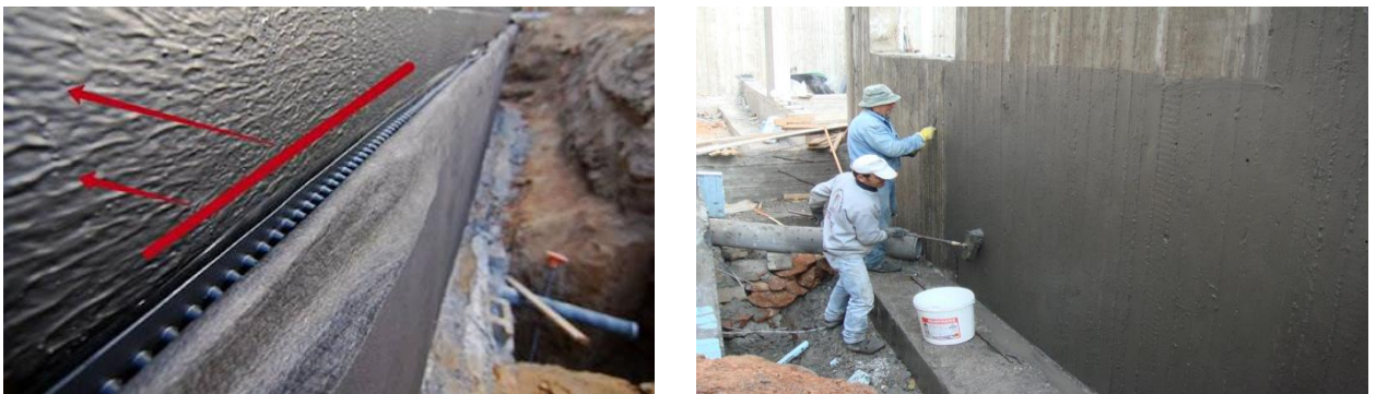
Рисунок 1.8 – Гідроізоляція проникаючої дії
