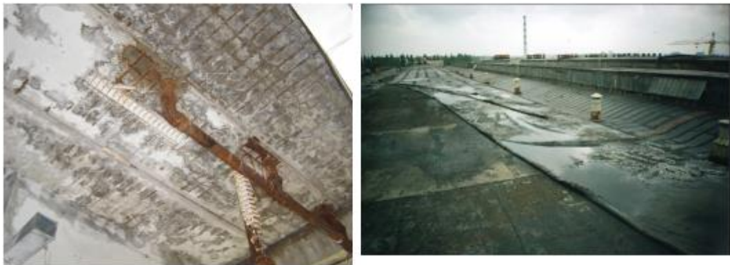
Рисунок 1.2 - Руйнування конструкцій внаслідок недостатньої площі обпирання
