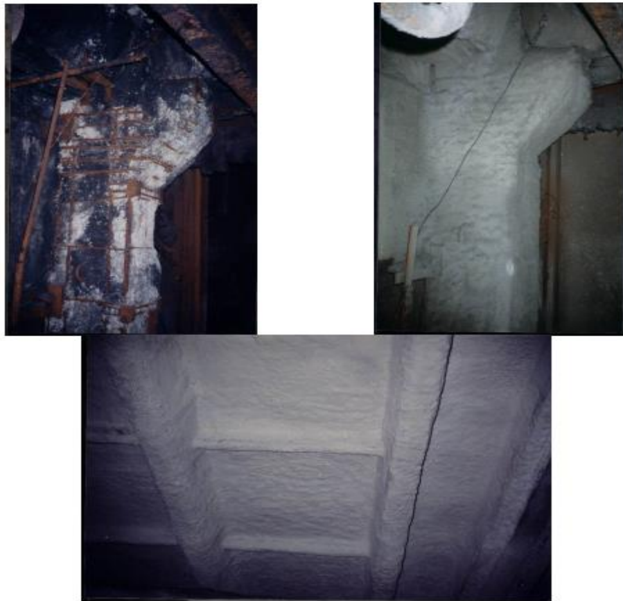
Рисунок 1.8 - Зовнішній вигляд поверхні конструкцій після їх відновлення сухим способом торкретування
