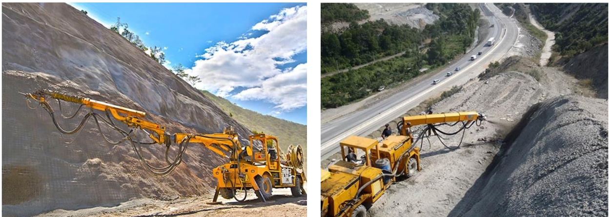
Рисунок 1.5 – Укріплення укосів з використанням торкретбетону
