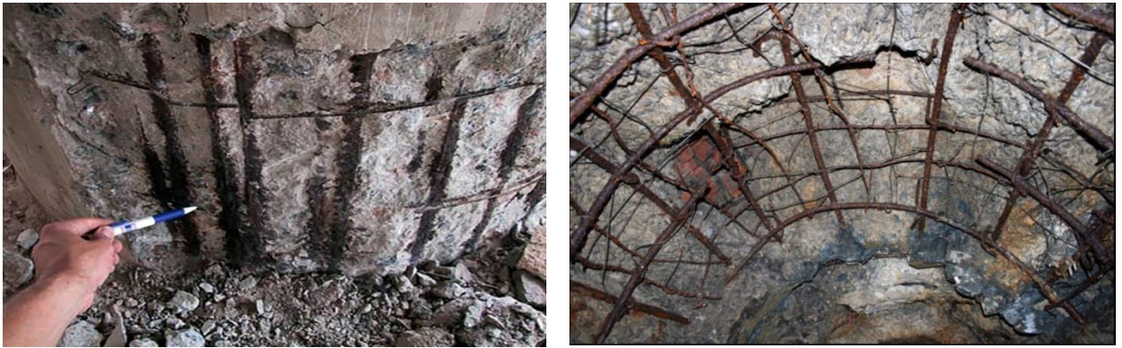
Рисунок 1.4 – Корозія бетону
