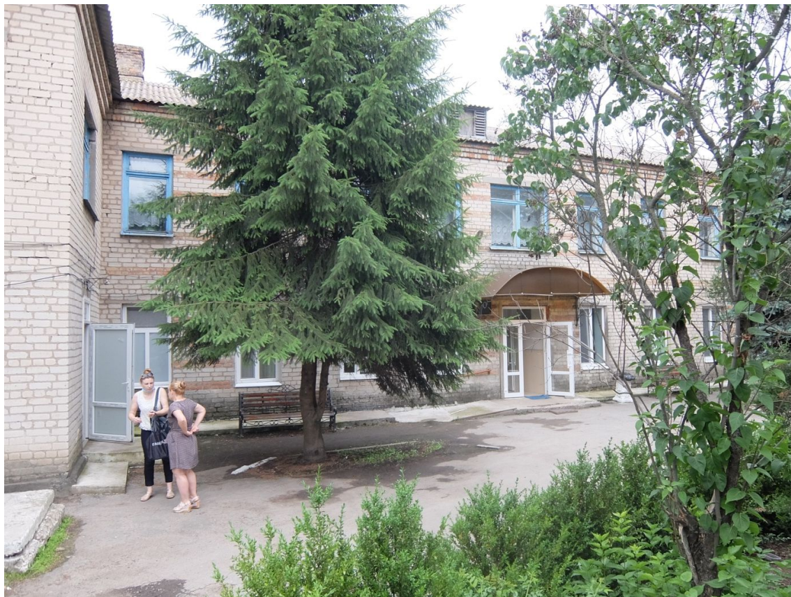
Рисунок 2.1 – Фасад будівлі вздовж осі Б (головний фасад)
