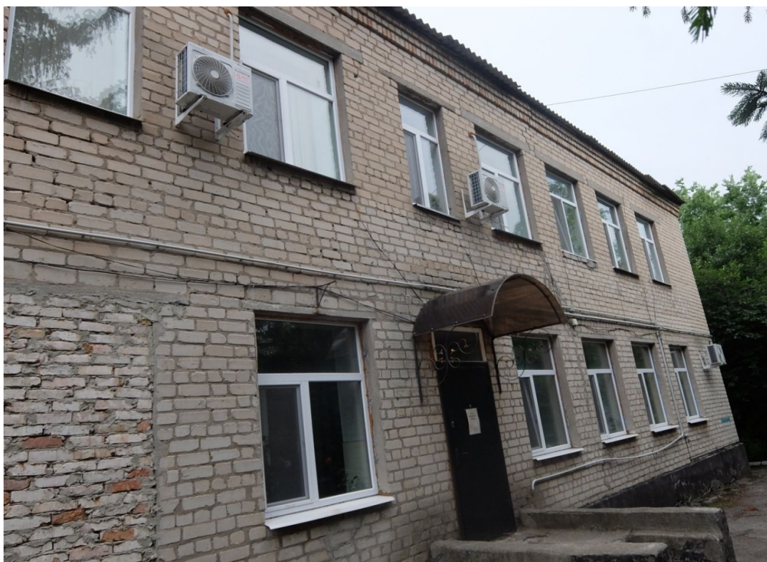
Рисунок 2.3 – Фасад будівлі вздовж осі 8 (боковий фасад)
