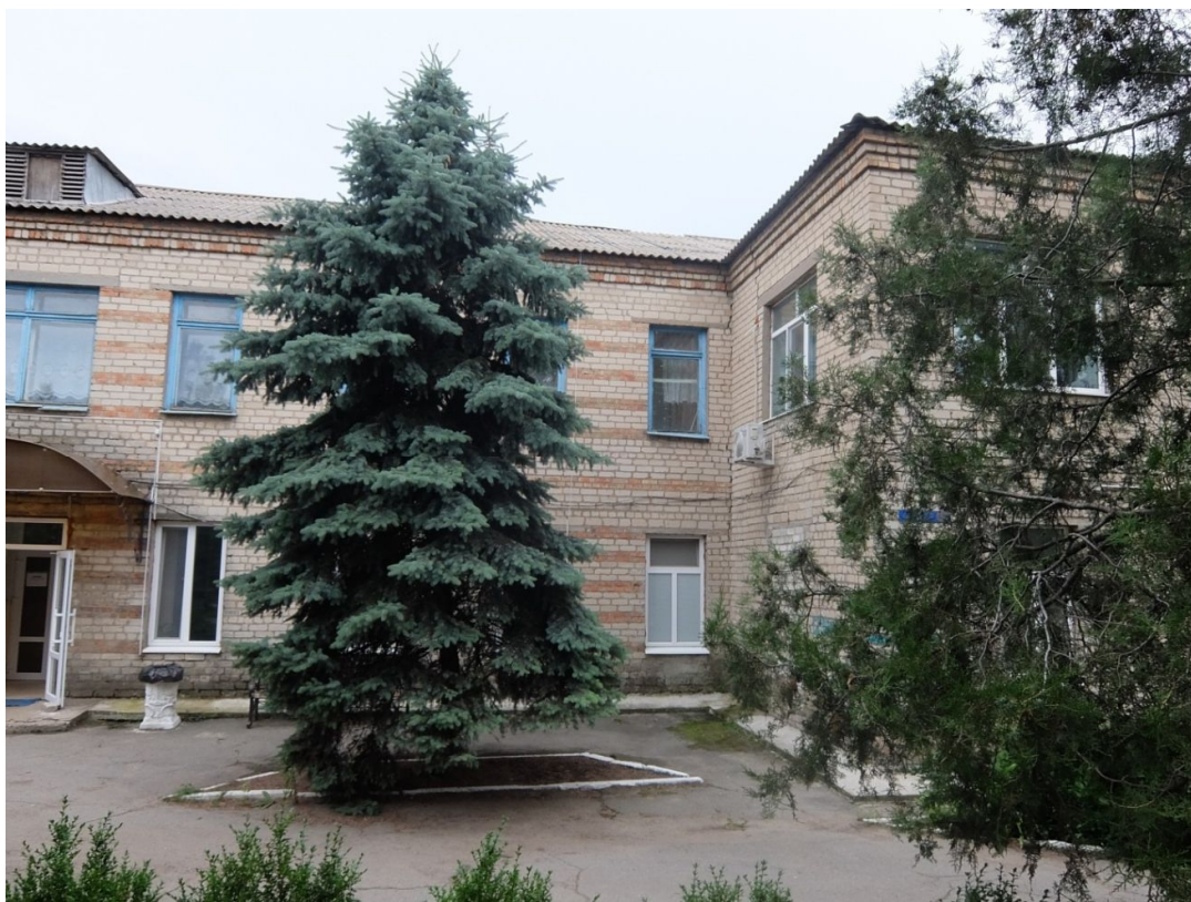
Рисунок 2.2 – Фасад будівлі вздовж осі Б (головний фасад)
