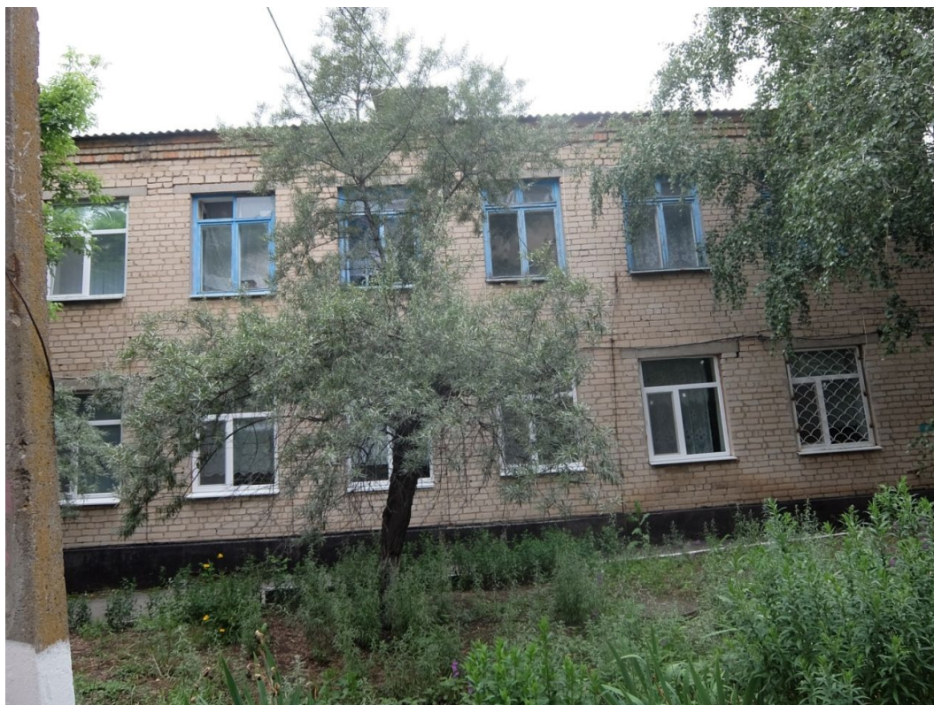
Рисунок 2.4 – Фасад будівлі вздовж осі 1 (боковий фасад)
