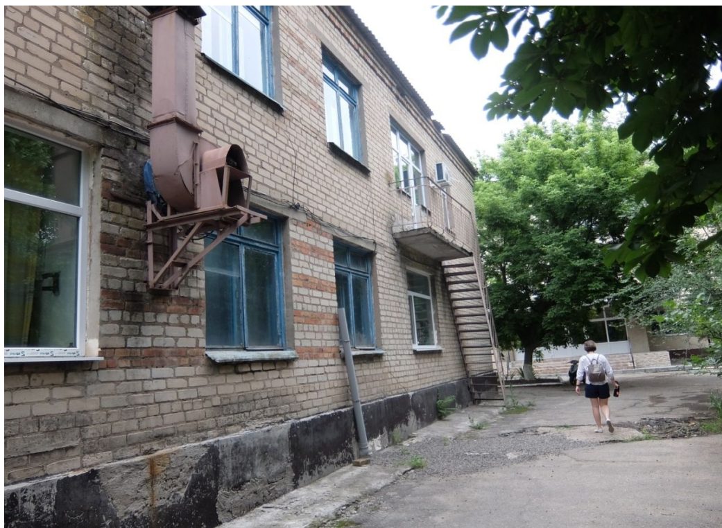
Рисунок 2.6 – Фасад будівлі вздовж осі Г (дворовий фасад)
