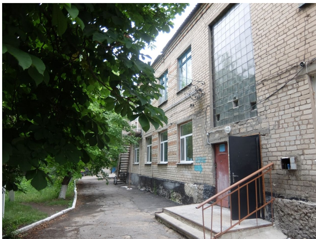
Рисунок 2.5 – Фасад будівлі вздовж осі Г (дворовий фасад)
