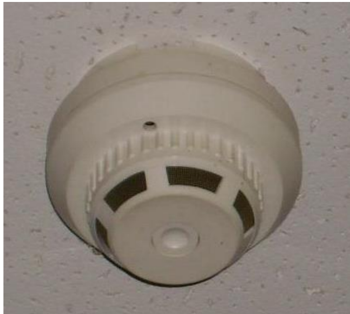
Рисунок 1.6- Точковий сповіщувач вмонтований на стелю
