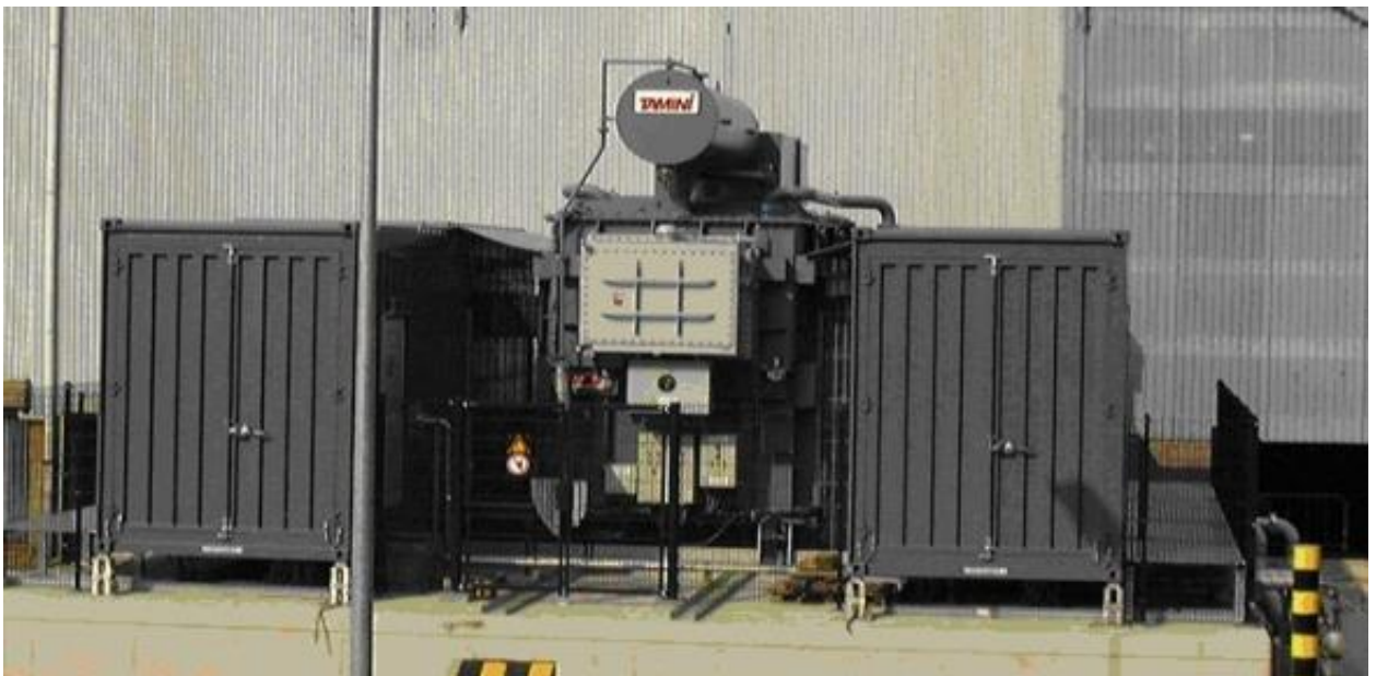
Рисунок 1.8 – Випрямляючий агрегат ВА-65000/300-УХЛ42
