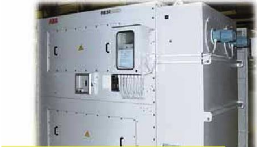
Рисунок 3.3 – Трансформатор з повітряно-водним охолодженням IP 54 виконаний для потреб гірничої промисловості
