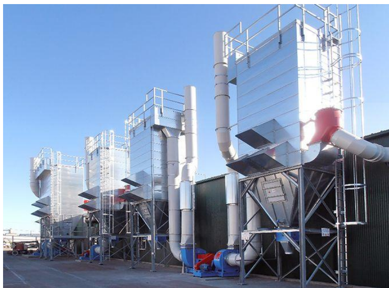
Рисунок 2.27 - Багатосекційна установка (батарея) рукавних фільтрів послідовного з'єднання.
