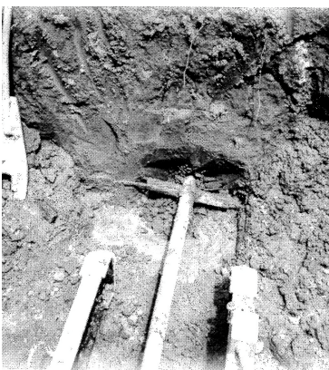
Рис.2. Процес початку утворення ГЦЕ існуючим бурозмішувачем
