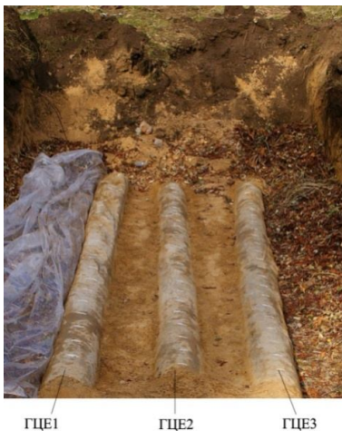
Рис.10. Розкриті ГЦЕ влаштовані по розробленій технології
