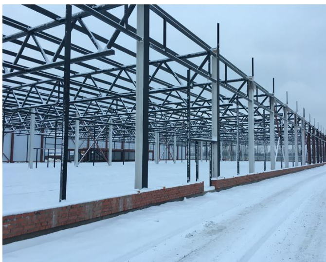
Рисунок 2.1 – Приклад роботи з монтажу металоконструкцій [17]
