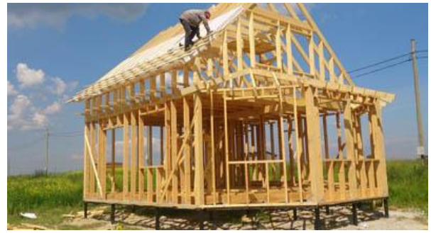
Рисунок 2.1 – Дерев'яно-каркасна технологія будівництва індивідуальних житлових будинків
