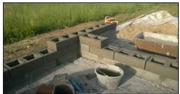
Рисунок 2.14 - Зведення стін за цією технологією ТІБЕ
