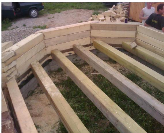
Рисунок. 2.8- Монтаж дерев'яного будинку з бруса
