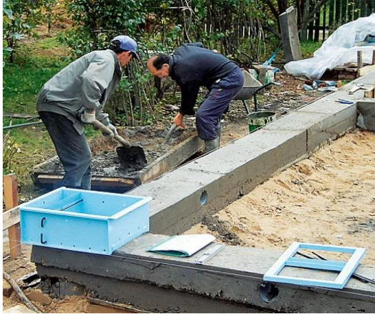
Рисунок 2.12 – Улаштування стрічкового ростверку
