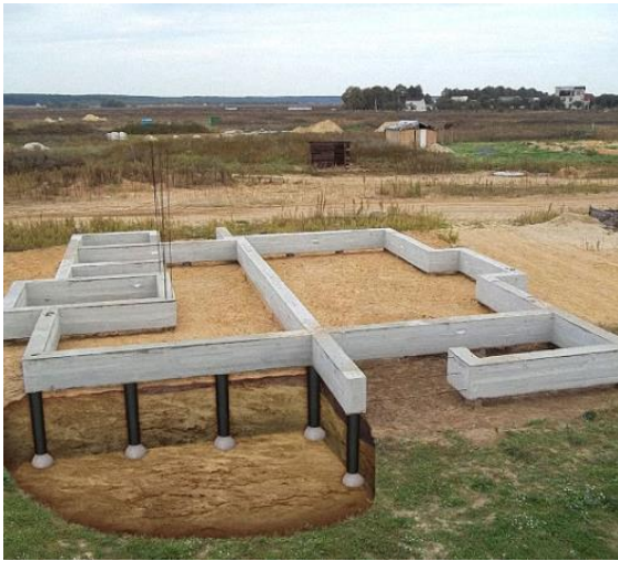
Рисунок 2.11 – Улаштування фундаменту по технології ТІБЕ
