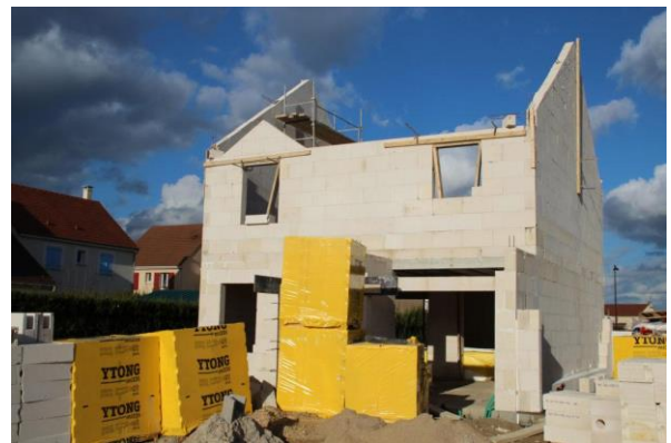
Рисунок 1.10 - Будівництво з газобетону
