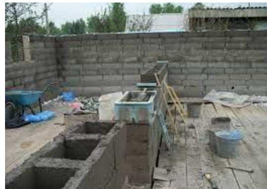
Рисунок 2.13 - Модулі для зведення стін за цією технологією ТІБЕ
