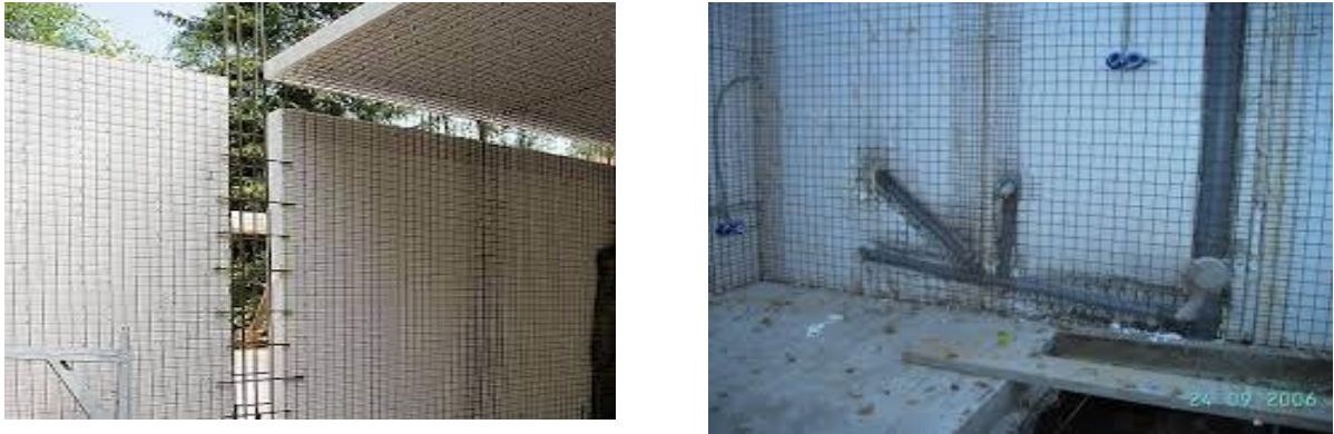
Рисунок 2.17 – Технологія плит перекриття та монтаж комунікацій
