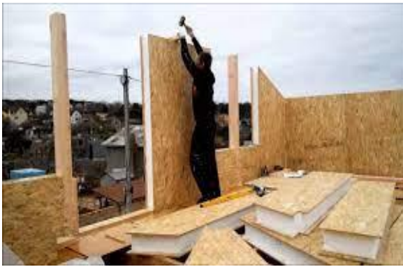
Рисунок 2.5 – Будівництво з використанням «сендвіч-панелі»
