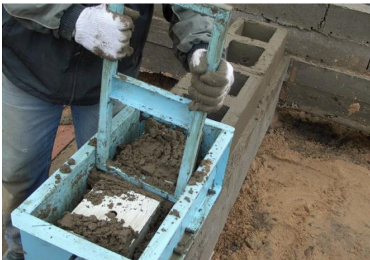
Рисунок 2.13 - Модулі для зведення стін за цією технологією ТІБЕ
