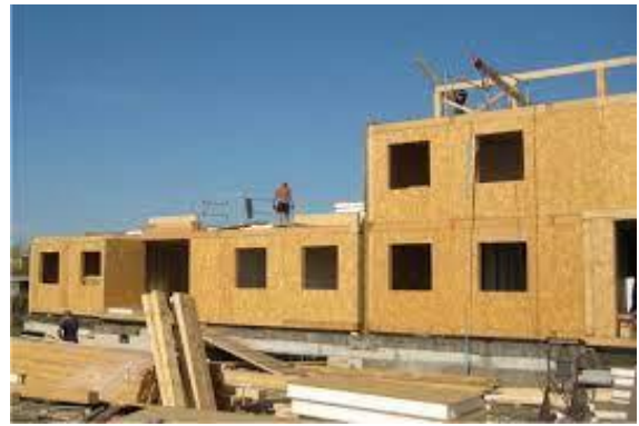
Рисунок 2.5 – Будівництво з використанням «сендвіч-панелі»
