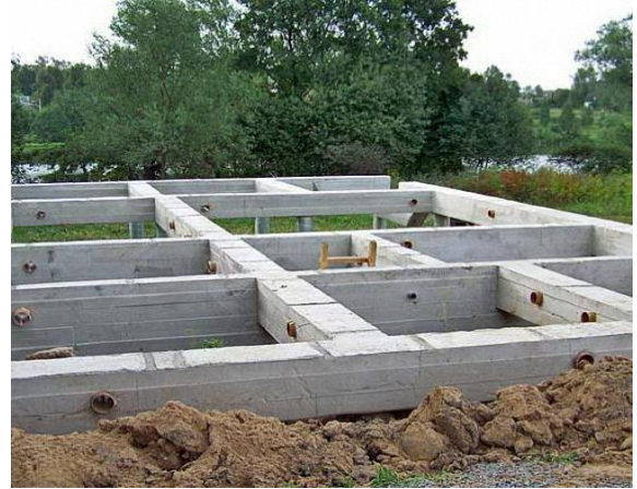
Рисунок 2.12 – Улаштування стрічкового ростверку
