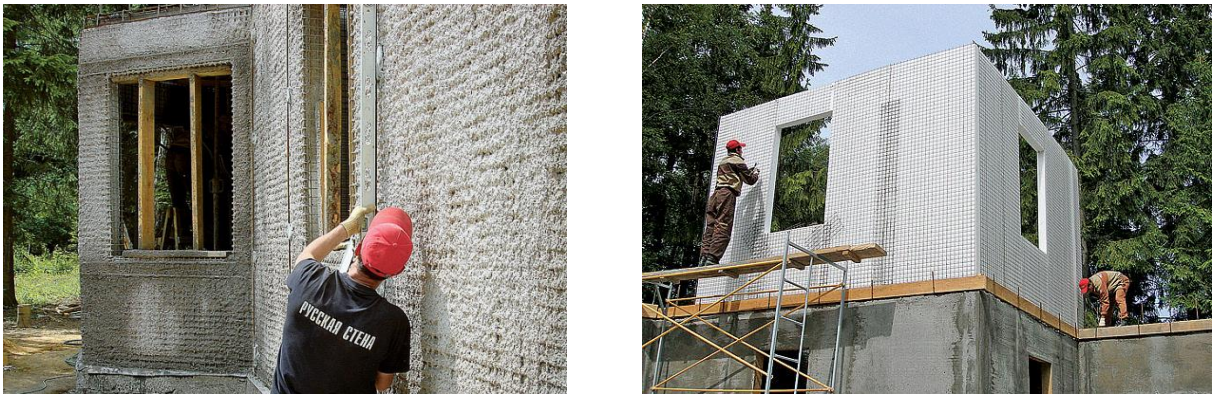
Рисунок 2.18 – Торкретування конструкцій
