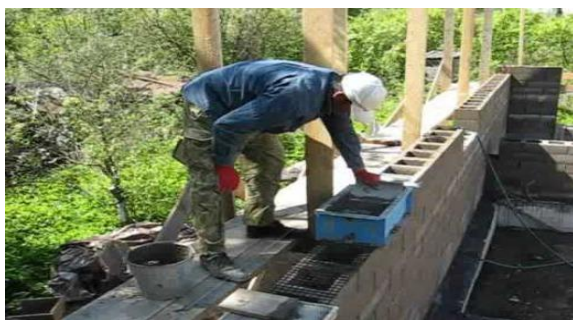
Рисунок 2.14 - Зведення стін за цією технологією ТІБЕ
