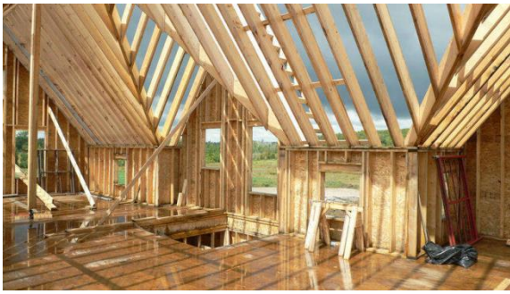
Рисунок 2.1 – Дерев'яно-каркасна технологія будівництва індивідуальних житлових будинків
