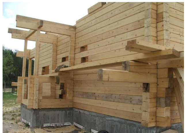
Рисунок. 2.8- Монтаж дерев'яного будинку з бруса
