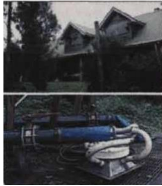
Рисунок 3.8 - Будинок на річці Джек. (зверху) Вигляд будинку. (знизу) Вид гідротурбіни
