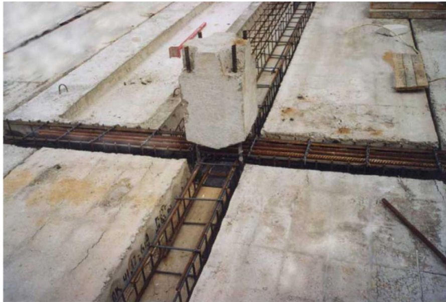
Малюнок 2.1 - Фрагмент збірно-монолітного каркаса серії Б1.020.1-7
