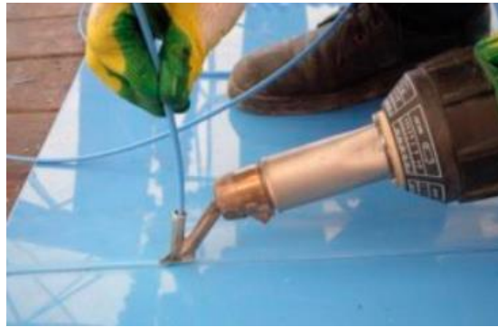
Рисунок 3.13 – Стикування полікарбонату за допомогою термосварки
