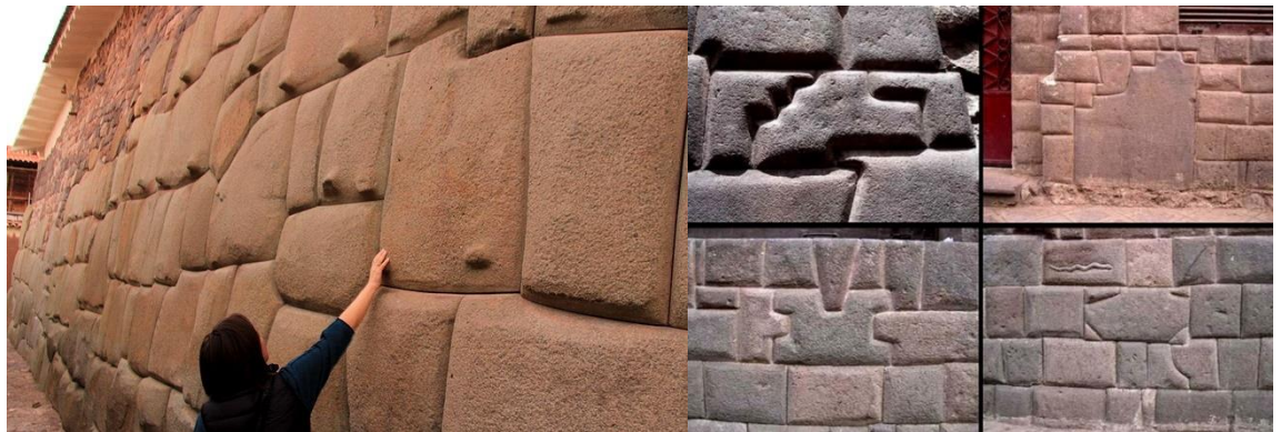
Рисунок 1.25 – Технологія полігональної кладки
