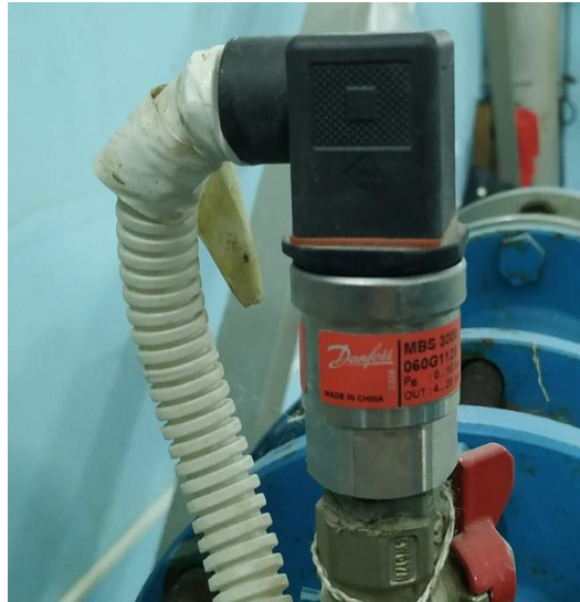
Рисунок 4.2 – Датчик тиску типу Danfoss MBS 3000
