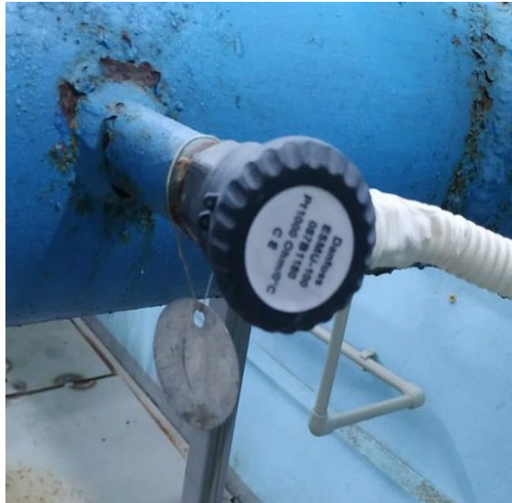
Рисунок 4.1 – Датчик температури типу ESMU
