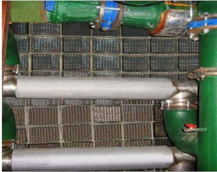
Рисунок 2.6 – Вузол теплообміну нової системи регулювання
